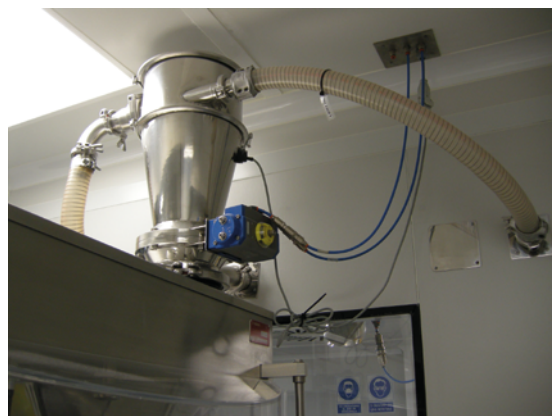
Scarico del prodotto miscelato
